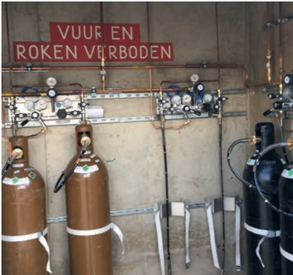
Elk aftappunt is voorzien van veilige koppelingen met drukmeters
